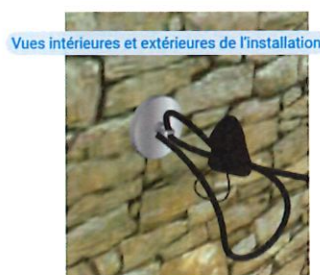
Fig.13 | DAFI : le dispositif d'ancrage façade par l'intérieur SOURCE : ORANGE
