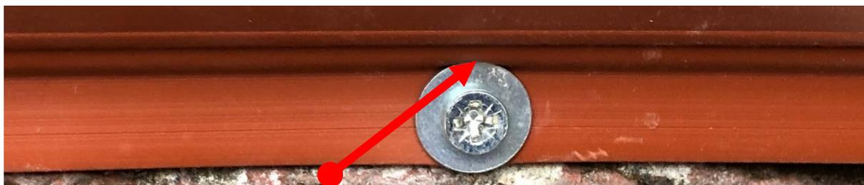
**TRES IMPORTANT : veuillez à ce que le haut de la rondelle soit en butée contre la lèvre où passe la tige métallique de façon à assurer le parfait placage du haut du CABLE COVER au mur.**
