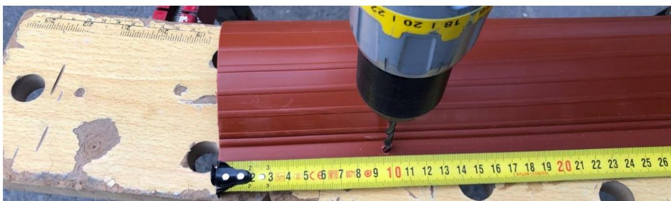
Il vous est conseillé de mettre 4 vis et rondelles sur la languette de fixation pour une longueur de 1.55 mètres.
